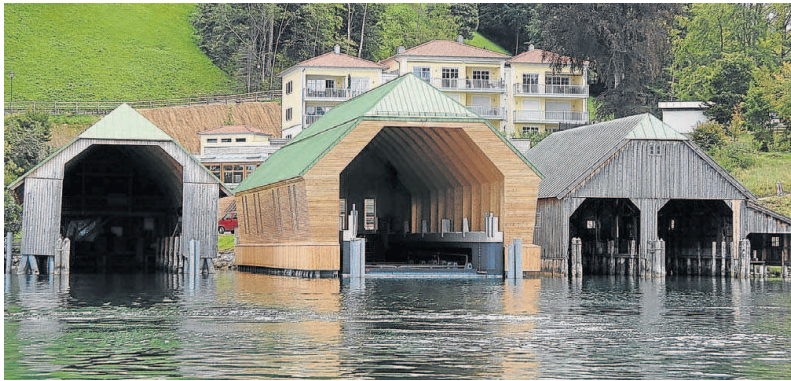
Die neue Werftanlage: In der Mitte das Schwimmdock der Schifffahrt Tegernsee.
